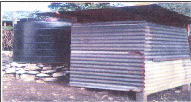
Foto 5: Se observa el mal estado del único tinaco del establecimiento educativo.
